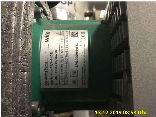
Heizkreispumpe 3/3a
