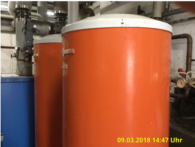
Warmwasserbereitung
