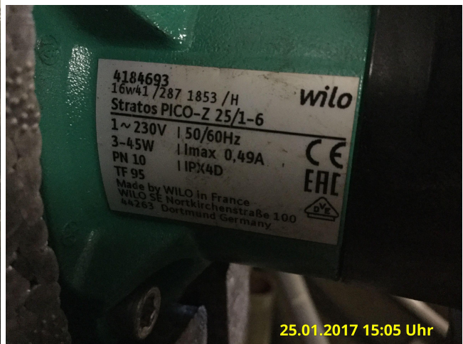
Zirkulationspumpe
