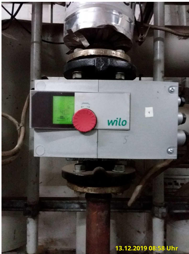
Heizkreispumpe 1
