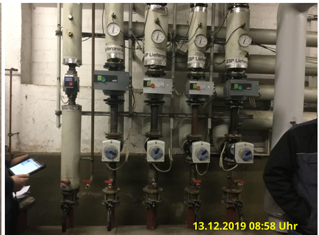
Heizkreispumpe 3/3a
