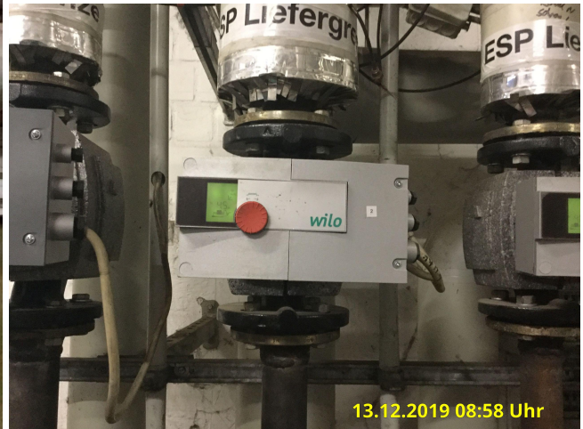
Heizkreispumpe 3/3a
