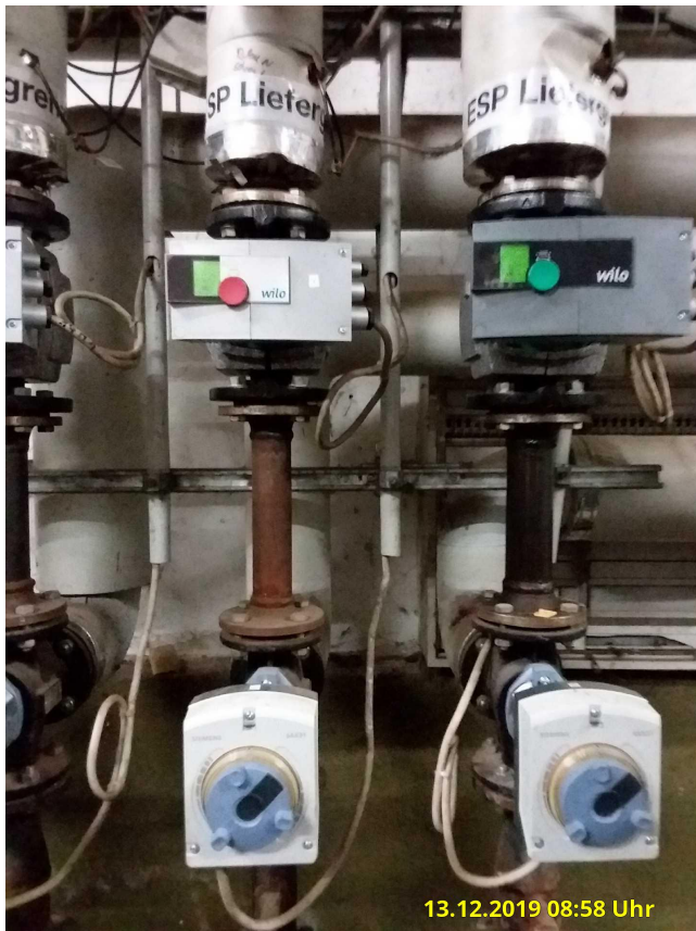
Heizkreispumpe 1
