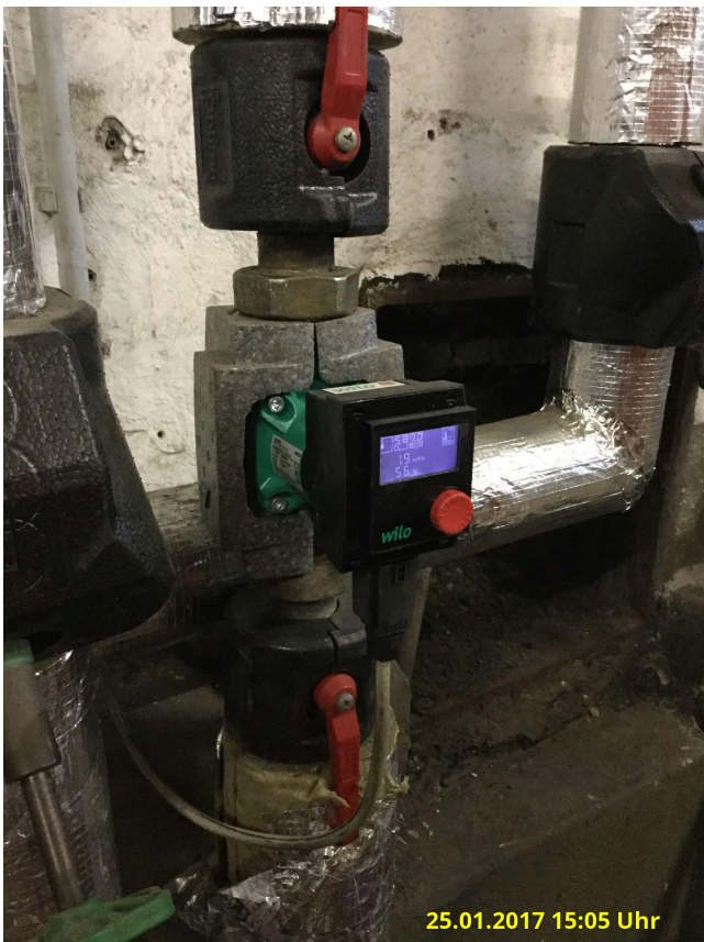
Zirkulationspumpe
